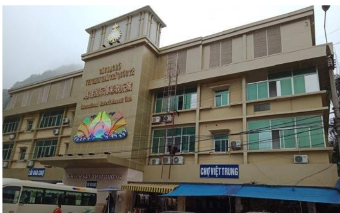
Hình 3.19: Hiện trạng công trình
