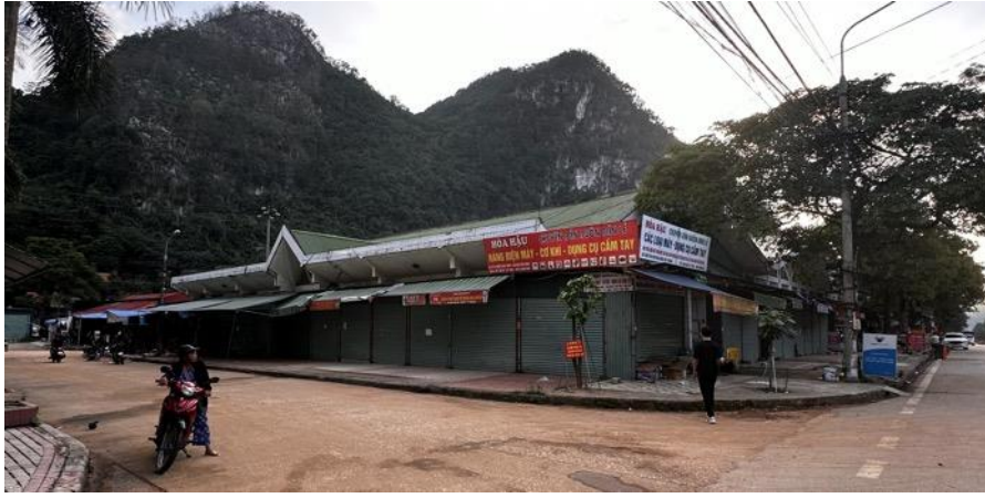
Hình 3.17: Hiện trạng công trình
